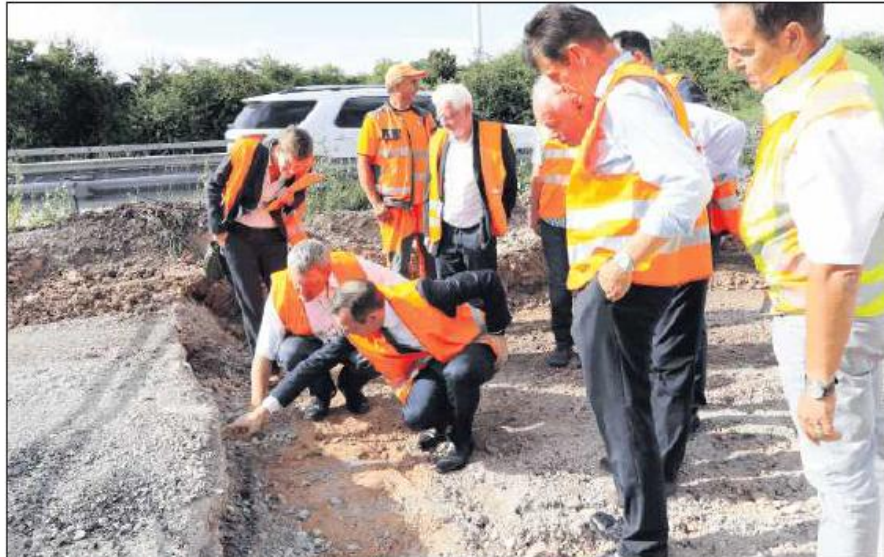
An dieser Brücke wird die Reichsautobahn als Unterbau bleiben: weil das Bauwerk erst vor kurzem saniert worden ist, im Vordergrund: Volker Wissing.
